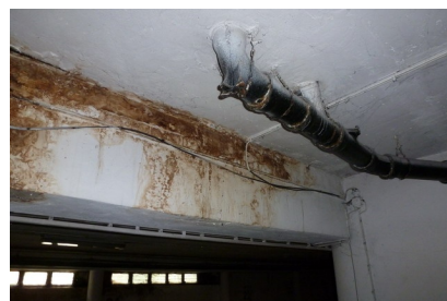
Pôvodný stav v objekte garáže
