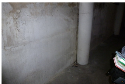
Pôvodný stav v objekte garáže
