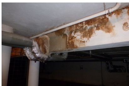
Pôvodný stav v objekte garáže
