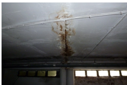
Pôvodný stav v objekte garáže
